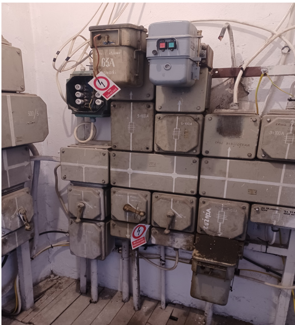
Ilustracja 1: Część istniejącej rozdzielni głównej RG
