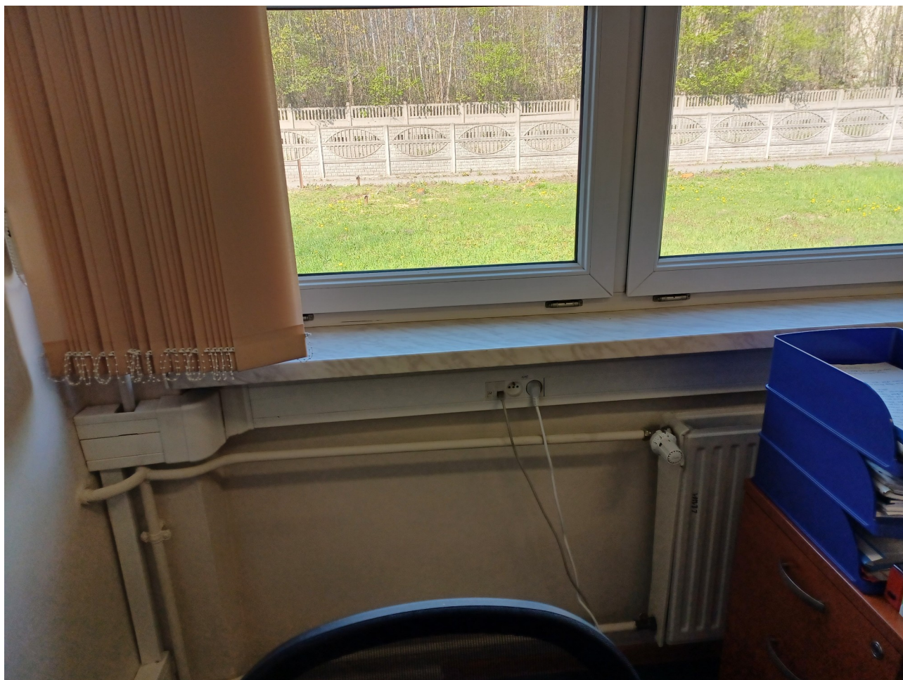
Ilustracja 7: Kanał instalacyjny biegnący wzdłuż ściany zewnętrznej przez pomieszczenia biurowe
