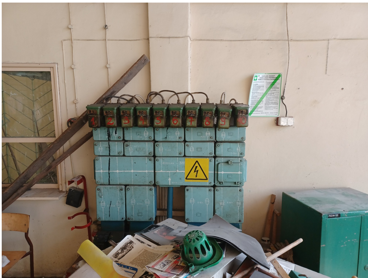
Ilustracja 2: Przykładowa rozdzielnica do likwidacji z pom. warsztatów szkolnych
