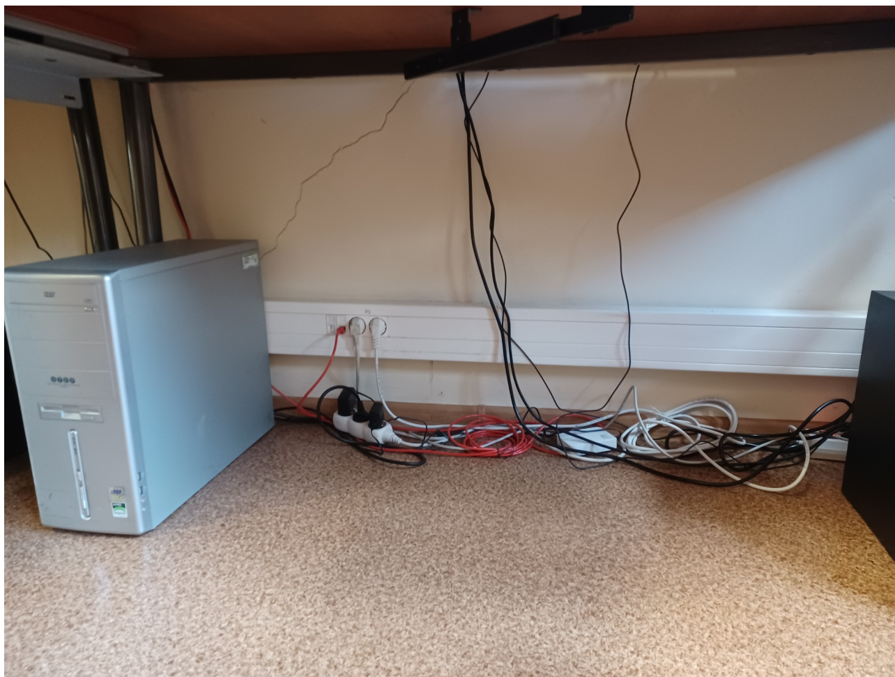
Ilustracja 9: Niewystarczająca ilość gniazd 230V
