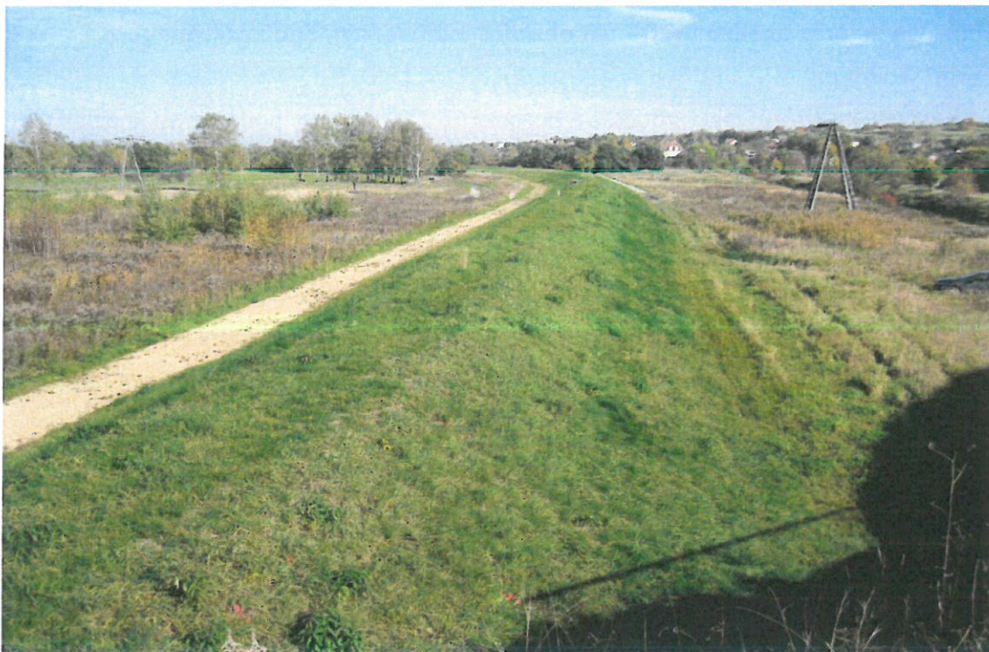
Rysunek 22 Zdjęcie Wału przeciwpowodziowego wybudowany przez Gminę na prawym brzegu rzeki Przemszy w km 4+753-6+652
