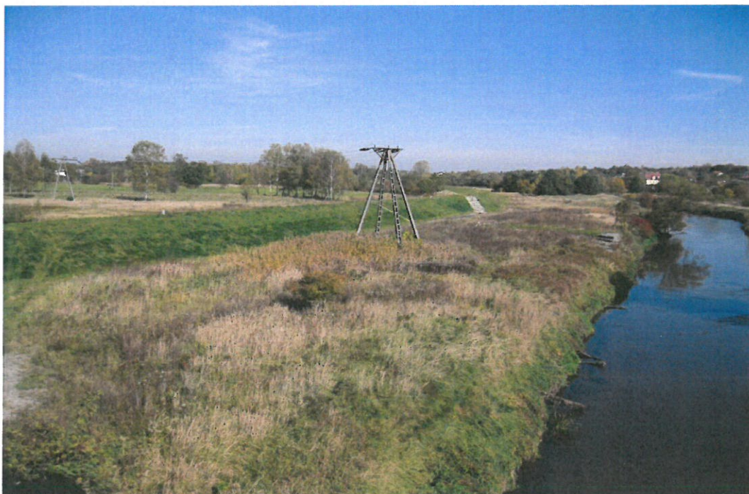
Rysunek 23 Zdjęcie Wału przeciwpowodziowego wybudowanego przez Gminę Chełm Śląski na prawym brzegu rzeki Przemszy
