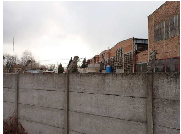
Fot. 11. Widok na zabudowę fabryki wentylatorów Fawent.
