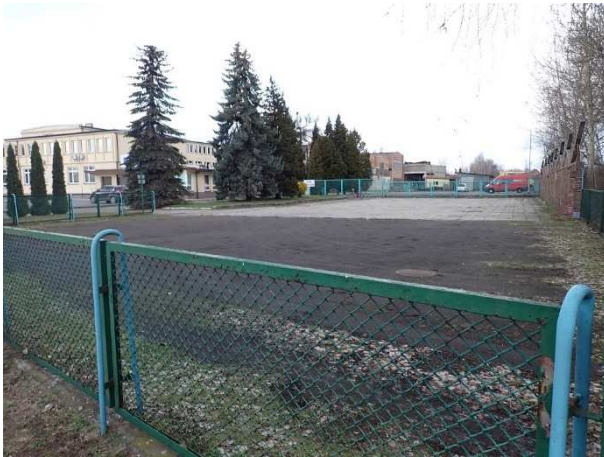
Fot. 8. Widok na zabudowę fabryki wentylatorów Fawent.
