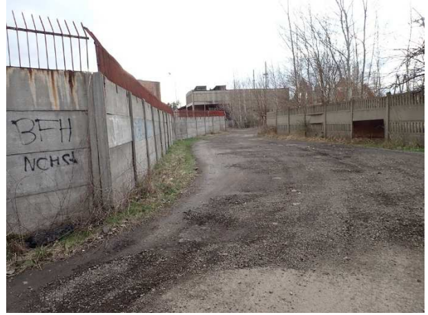
Fot. 10. Widok na zabudowę fabryki wentylatorów Fawent.
